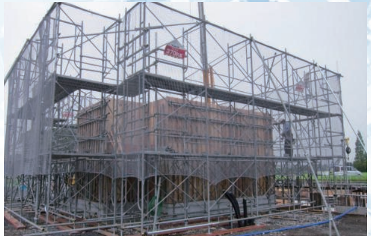
中継放送所/局舎建築工事
