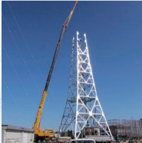
中継放送所/鉄塔建設工事
