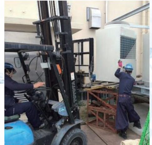
ラジオ放送所/空調設備工事
