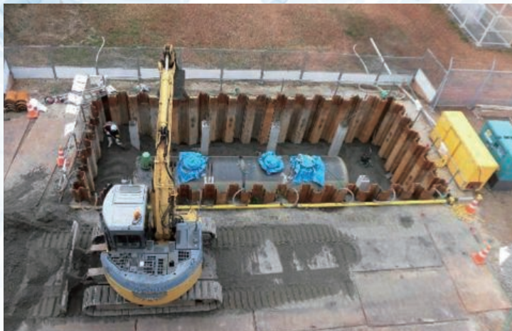
ラジオ放送所/地下オイルタンク工事
